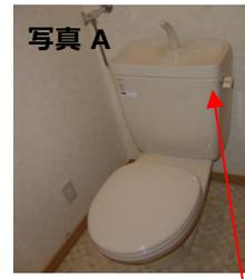
パイプは水平に倒し固定させる
