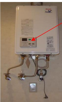
← 給湯器は電源を入れた状態にして下さい。電源が入っていると凍結防止ヒーターが作動して、給湯器内に残っている水は凍結しません。
