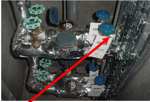
青色のバルブのみ完全に閉めて下さい
