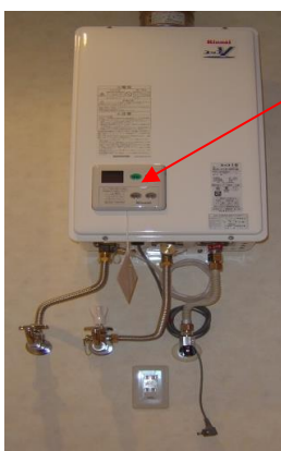
水抜き栓を開けて残水を出す
