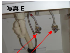
水抜き栓を開けて残水を出す
