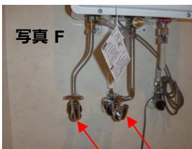
水抜き栓を開けて残水を出す
